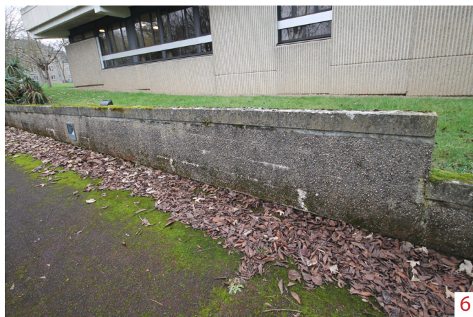
Epaufures, fissures du béton, colonisation biologique
