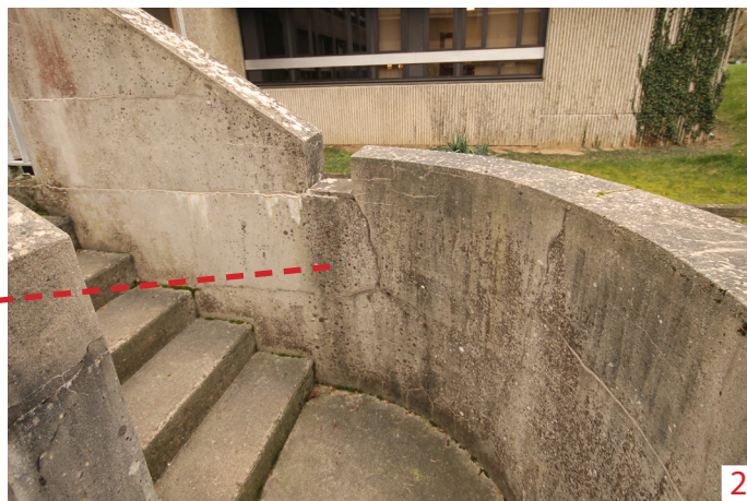
Fissures, colonisation biologique, traces de ruissellement
