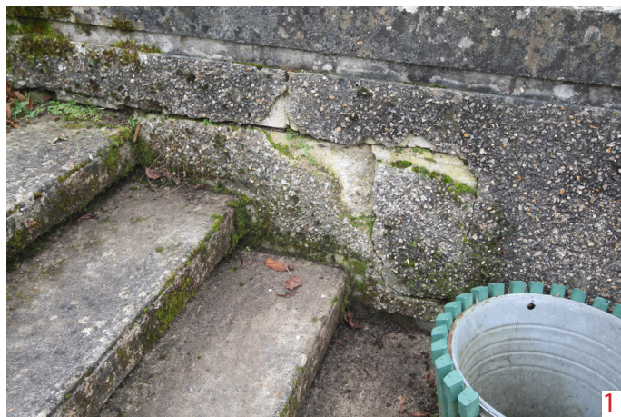
Eclatement du béton, fissures
