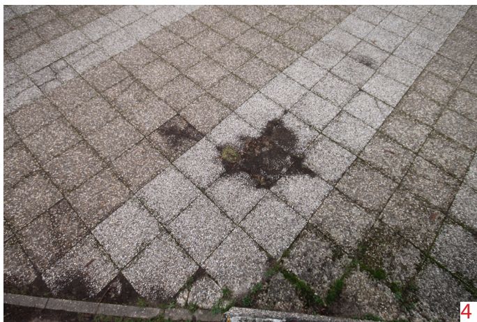
Déformation du pavement du parvis, colonisation biologique, humidité
