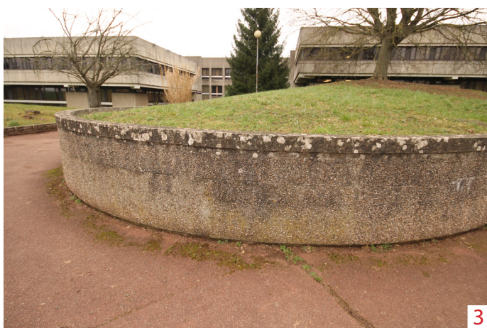
Fissures, efflorescences salines, colonisation biologique
