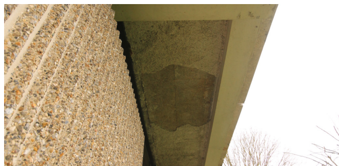
Altération du flocage isolant en sous face
