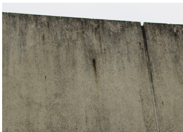
Coulures de pyrite de fer oxydée et salissures dues au ruissellement des eaux de pluie
