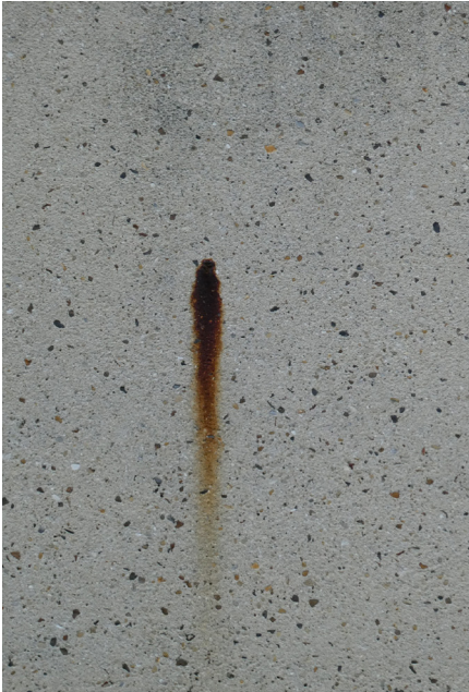
Coulures de pyrite de fer oxydée
