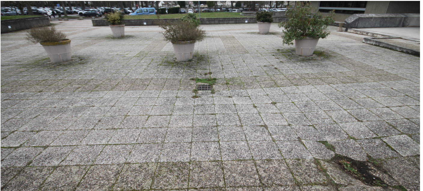
Déformation du pavement, colonisation biologique, humidité
