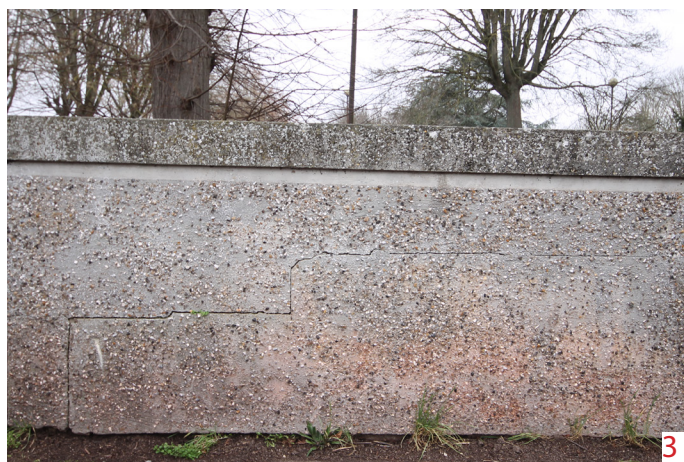
Fissure structurelle du béton
