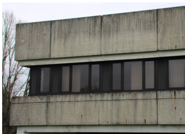
Salissures dues au ruissellement des eaux de pluie, coulures de pyrite de fer oxydée
