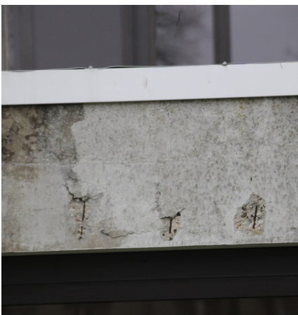
Eclatement des bétons, mise à nu des armatures
