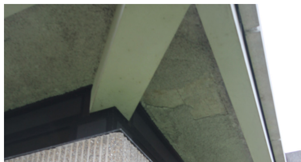
Altération du flockage isolant en sous face
