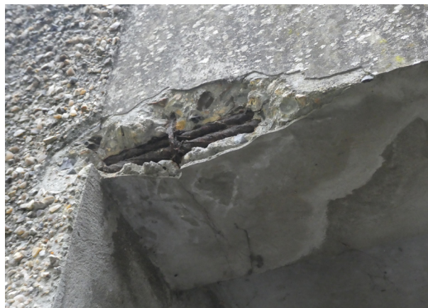
Eclatement des bétons, mise à nu des armatures
