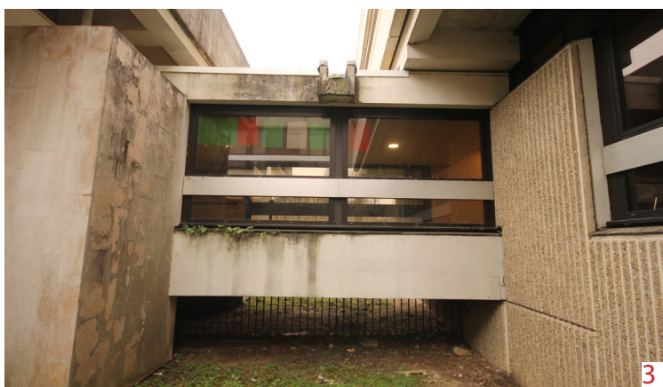
Colonisation biologique, salissures dues au ruissellement des eaux de pluie
