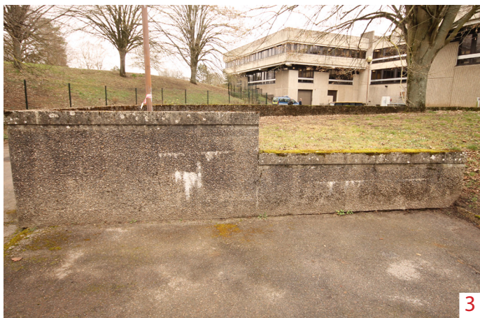
Fissuration des bétons, épauffrures, efflorescences salines, salissures dues au ruissellement, colonisation biologique
