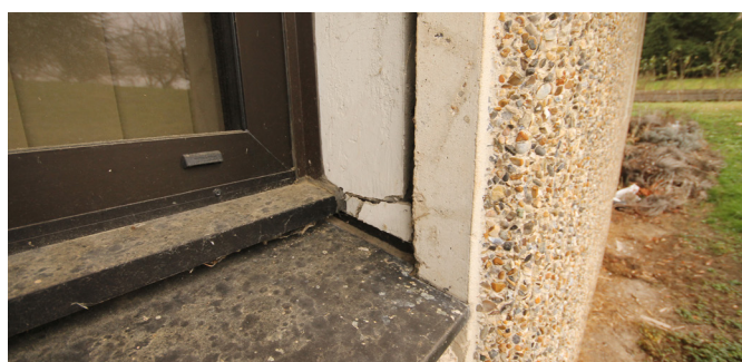
Eclatement du béton des ébrasements
