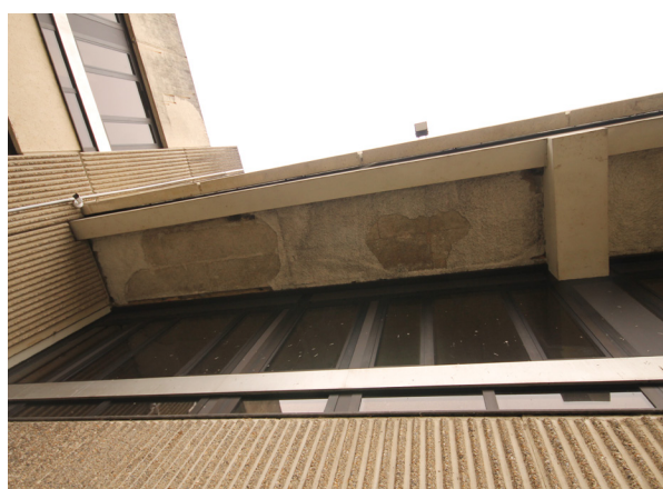
Altération du flocage isolant en sous face
