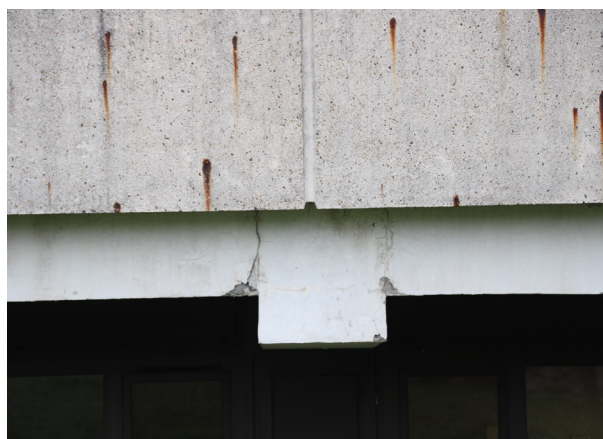
Fissures, épaufures, coulures de pyrite de fer oxydée
