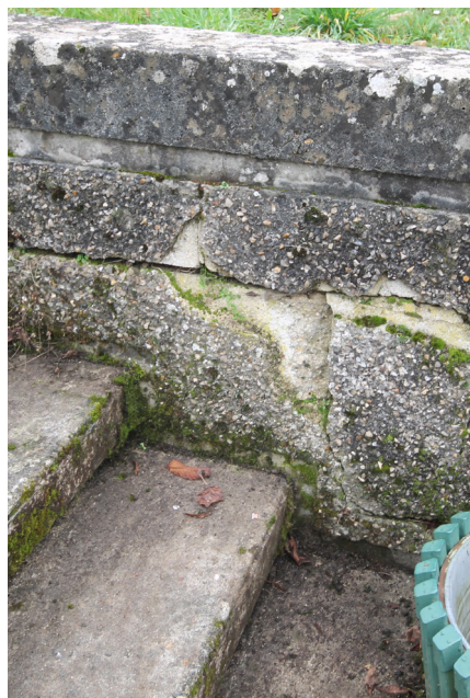
Casse du béton, fissures
