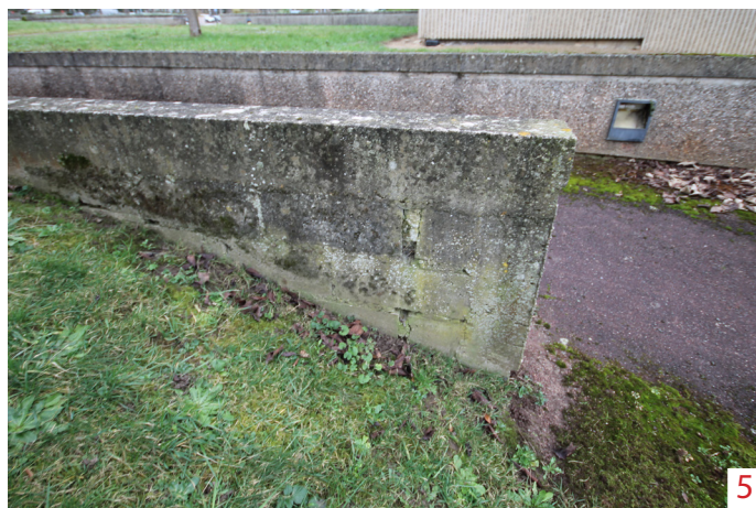
Déjointement, colonisation biologique, humidité, salissures
