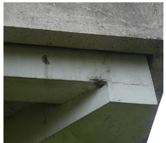
Eclatement des bétons, mise à nu des armatures, fissures
