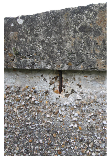
Eclatement du béton, mise à nu des armatures qui s'oxydent
