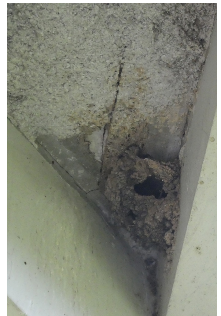
Altération du flocage et nid d'hirondelle
