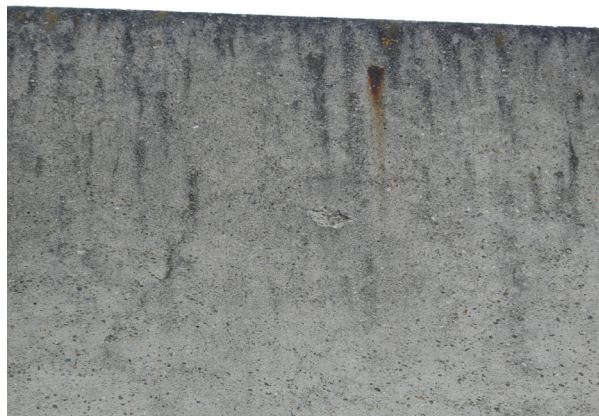
Salissures dues au ruissellement des eaux de pluie, coulures de pyrite de fer oxydée
