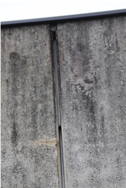
Altération du joint entre les panneaux
