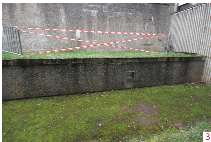
Colonisation biologique, humidité, salissures dues au ruissellement
