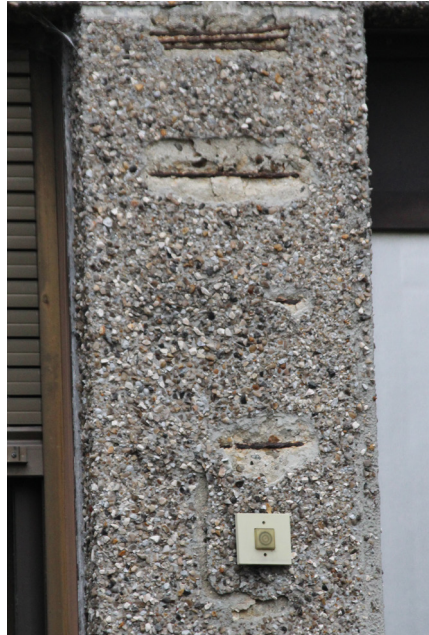
Armatures mises à nu, éclatement des béton
