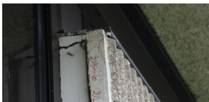
Eclatement du béton des ébrasements
