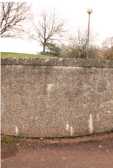
Fissures, épaufrures, sels
