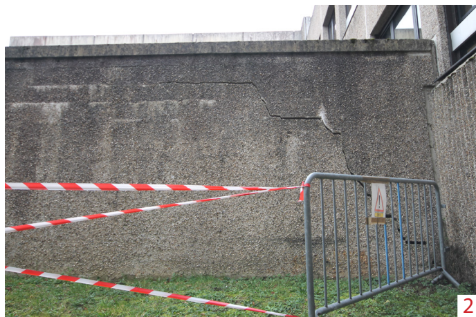
Fissures, épaufures, salissures dues au ruissellement, humidité
