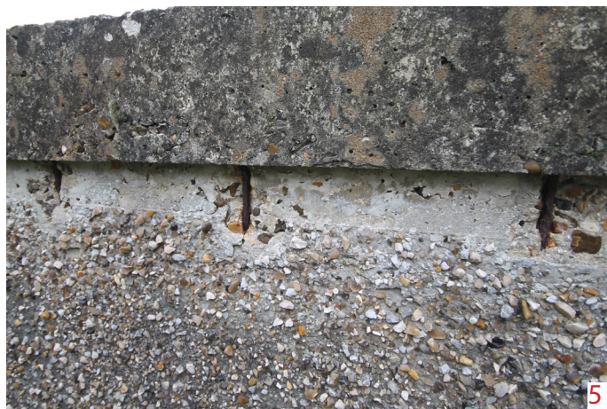
Eclatement du béton, mise à nu des armatures qui s'oxydent
