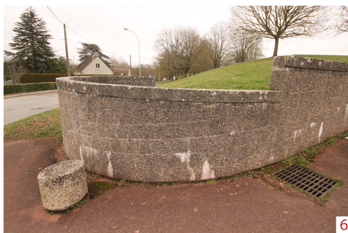
Fissuration des bordures en limite de propriété, épaufures, efflorescences salines, colonisation biologique
